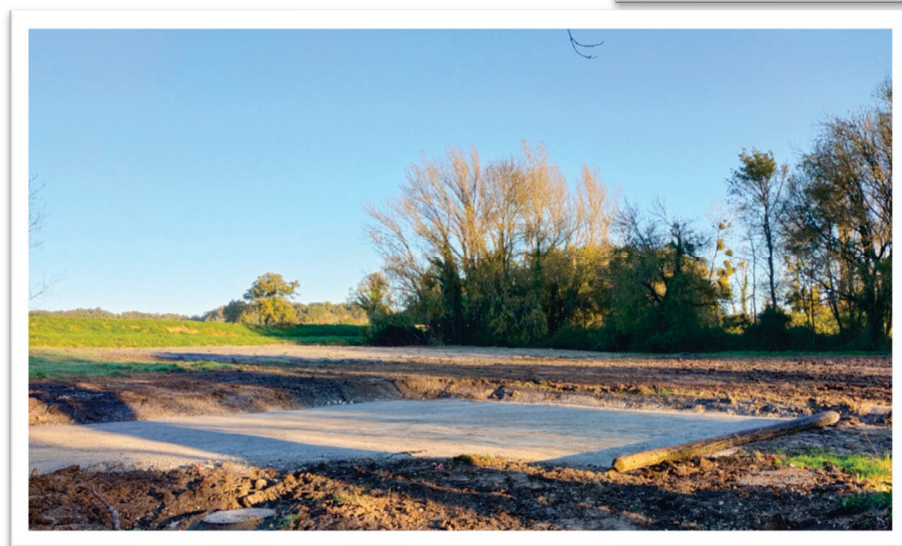
Création de l'aire de pompage
